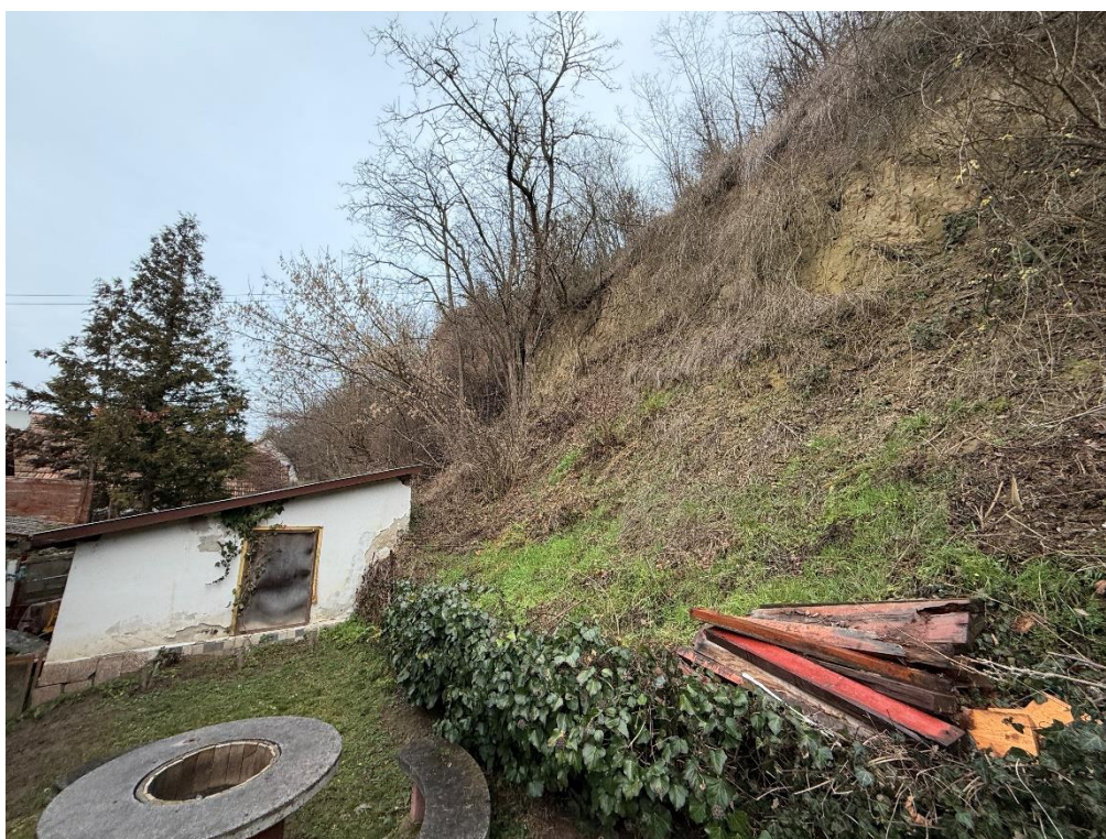
2. kép: Zelegény, Szőnyi utca 15. omladozó partfal a melléképület fölött
