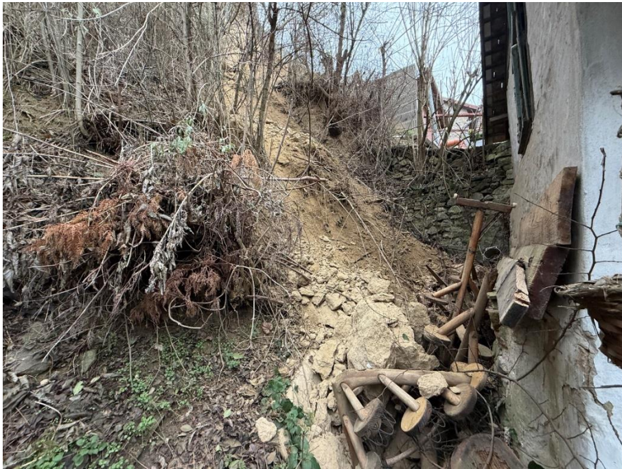
9. kép: Zelegény, Kálvária u. 2., leomlott partfal az épület mögött
